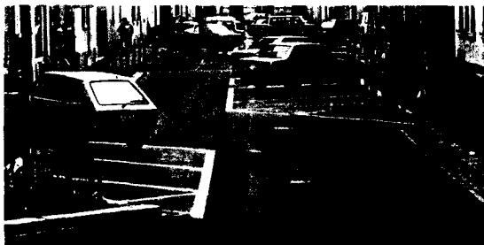
Abb. 4 Horizontaler Versatz durch bauliche Umgestaltung
