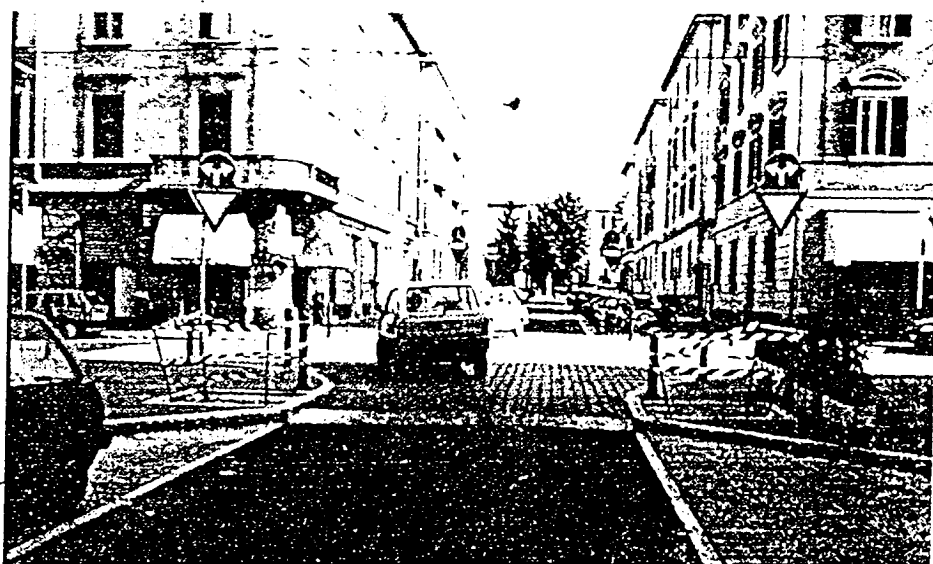
Particolare di un incrocio in via Vittorio Veneto, a Bologna, con dossi e parcheggi sistemati secondo le indicazioni contenute nell'abaco.
